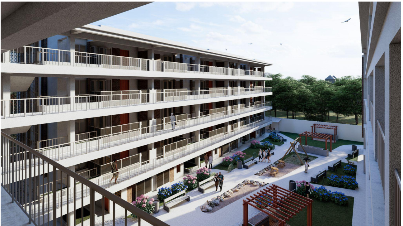
Vista hacia el patio interno infantil y quinchos desde el vecindario deportivo, nivel 4 - Bueno,E. 2021
