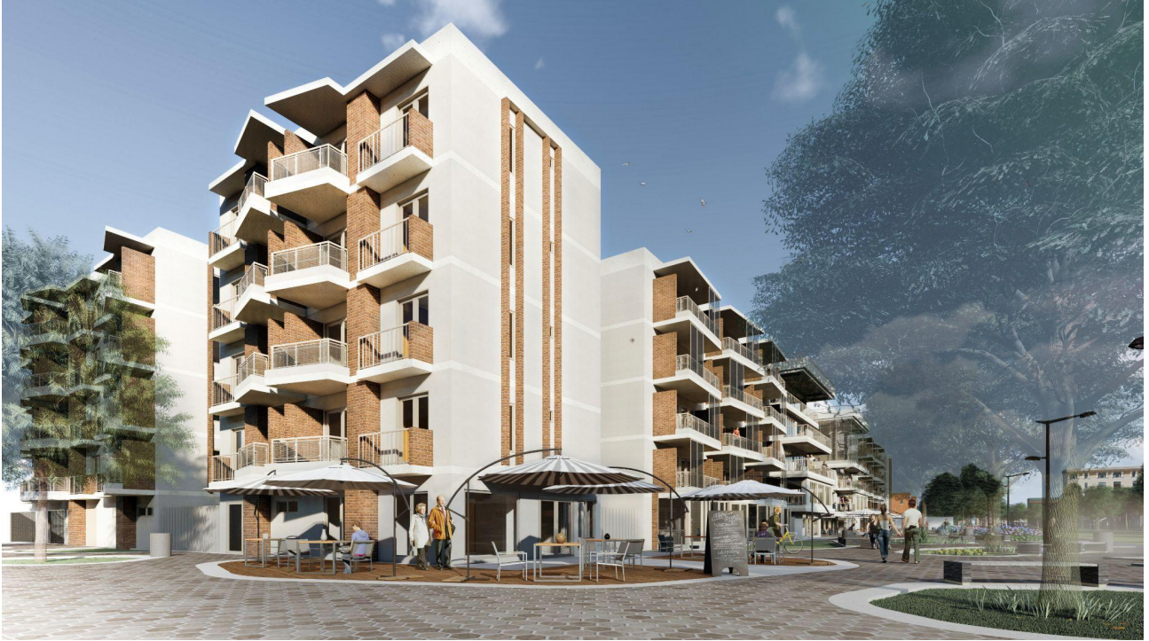
Esquina de Av. Departamental con Segunda Transversal Acceso secundario al edificio - Bueno,E. 2021
