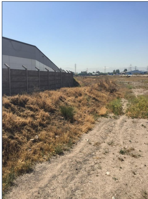
Fotografía 6. Terreno de Ampliación Vista Sur Oriente
