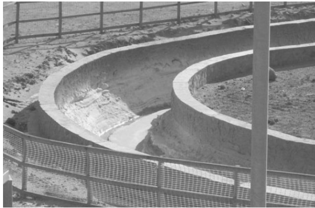
Figura 1.1: Canal de sección trapezoidal, Chuquicamata [2]
