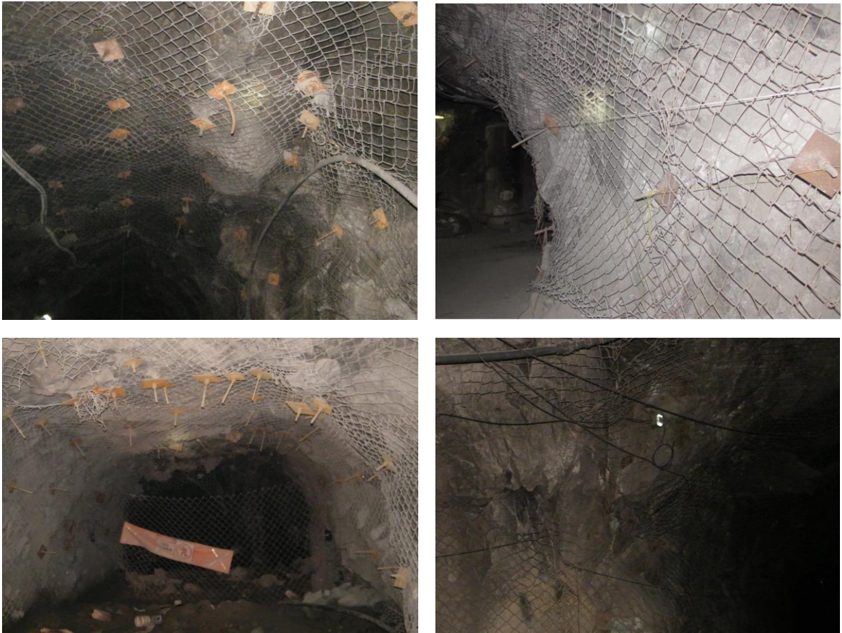
Figura 55 Condición de galerías y pilares antes de la tronadura en nivel CAL techo de caserón E01, proyecto CAL. (Zarate A, Lagos C, 2018)
