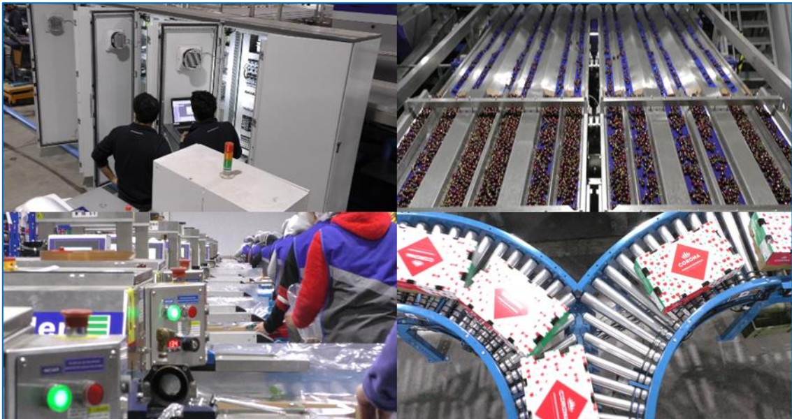
Ilustración 12. Registro fotográfico servicio de gestión montaje (2) Fuente: Departamento de Ingeniería Copefrut S.A.
