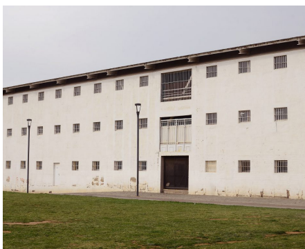
Fig 47: Edificio de Transmisión.
