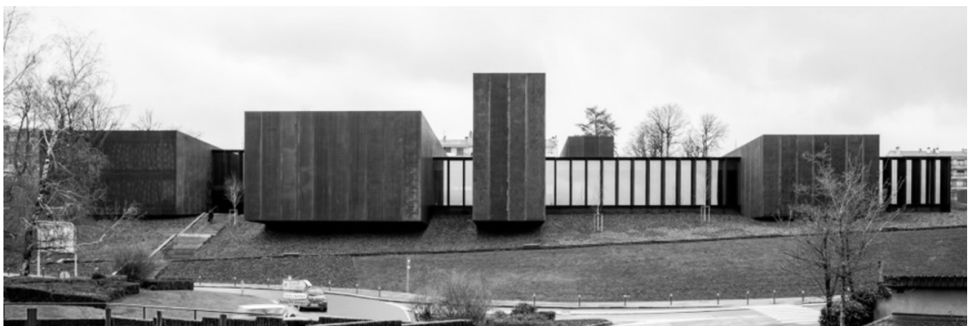
Fig 49. Fachada hacia la ciudad
