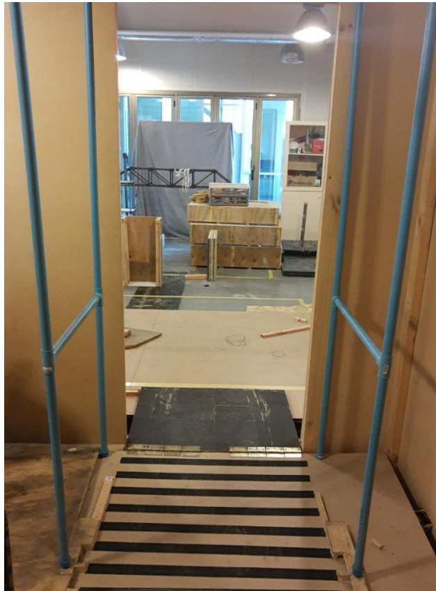
Ilustración 11-I: Rampa de acceso.
