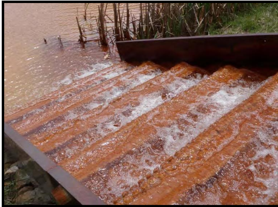
Figura 5.33 Canal de aireación escalonado.
