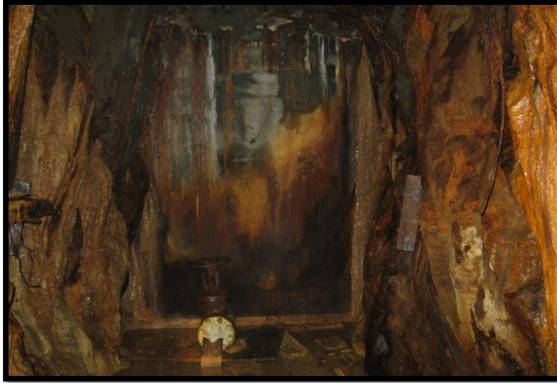
Figura 2.11 Tapón instalado en el Túnel Koehler.
