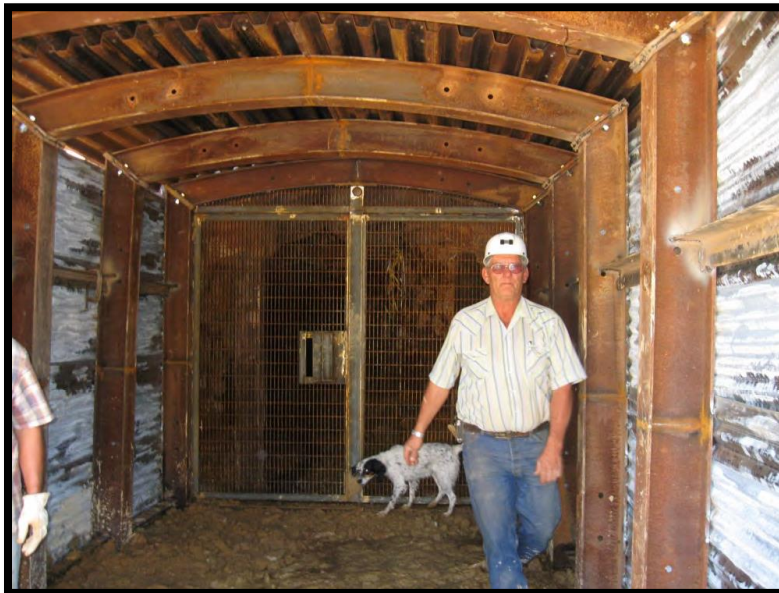
Figura 2.8 Portal del Túnel Koehler.
