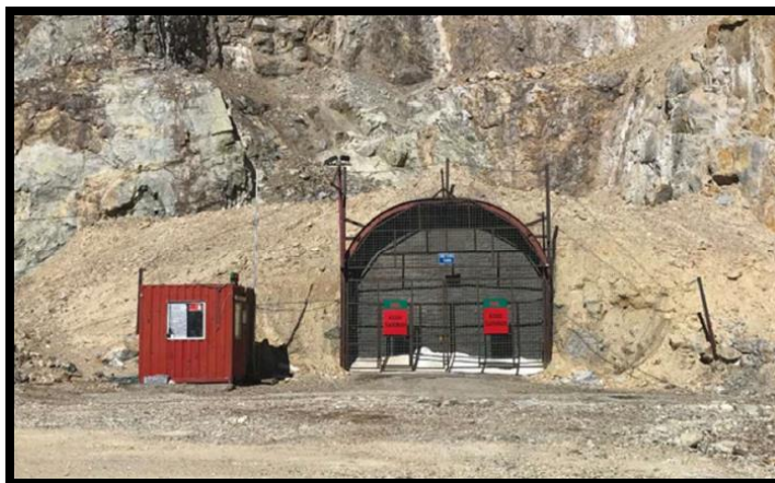
Figura 5.44 Cierre sólido del portal del túnel.
