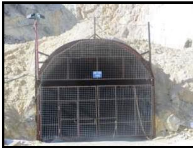
Figura 5.3 Portal del túnel en su condición de cierre temporal.
