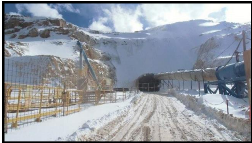
Figura 5.6 Acumulación de nieve sobre el portal.
