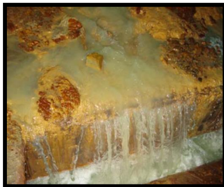
Figura 2.29 Cuneta de conducción de drenaje ácido del Adit 71.
