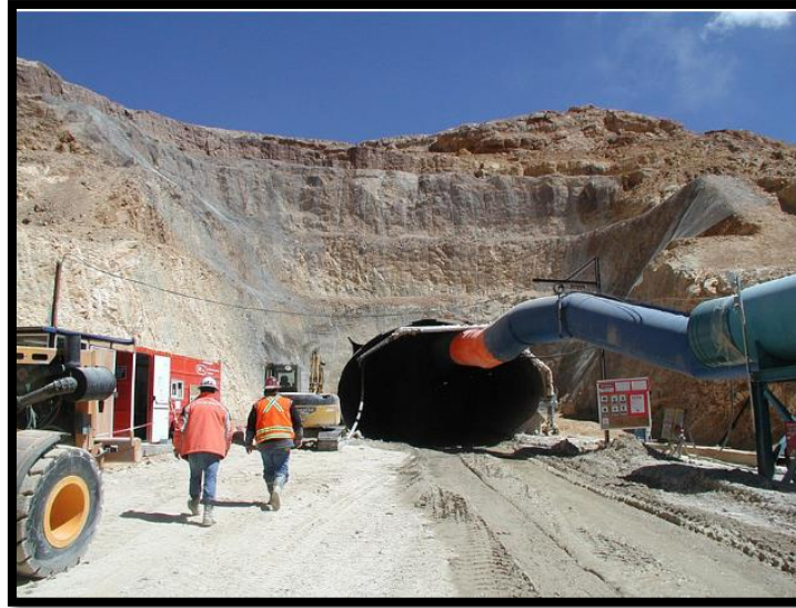
Figura 5.4 Portal del túnel.
