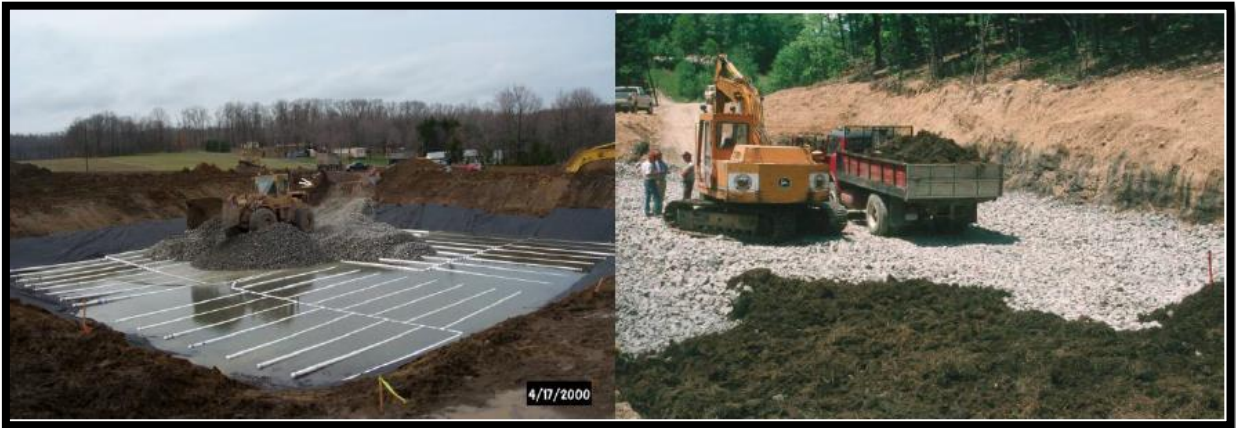
Figura 5.37 Construcción de un SAPS.
