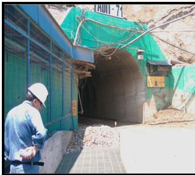
Figura 2.28 Punto de muestreo en el Adit 71.
