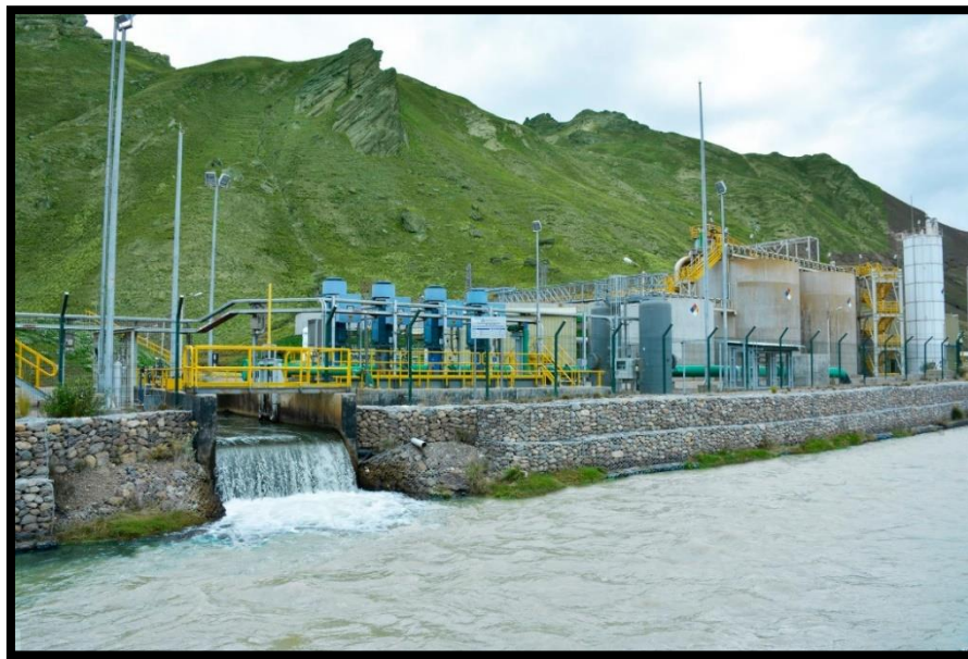
Figura 2.23 Planta de tratamiento de aguas ácidas del Túnel Kingsmill.
