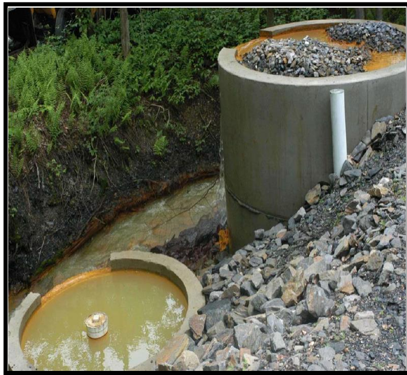
Figura 5.29 Vista real de un pozo de desviación de caliza.
