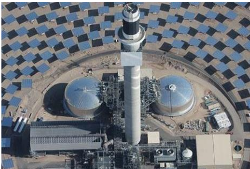
Figura 3 - 21: Sistema de almacenamiento de 10 horas con sales fundidas para planta solar de 100 MW en Crescent Dunes, CA, USA [90]
