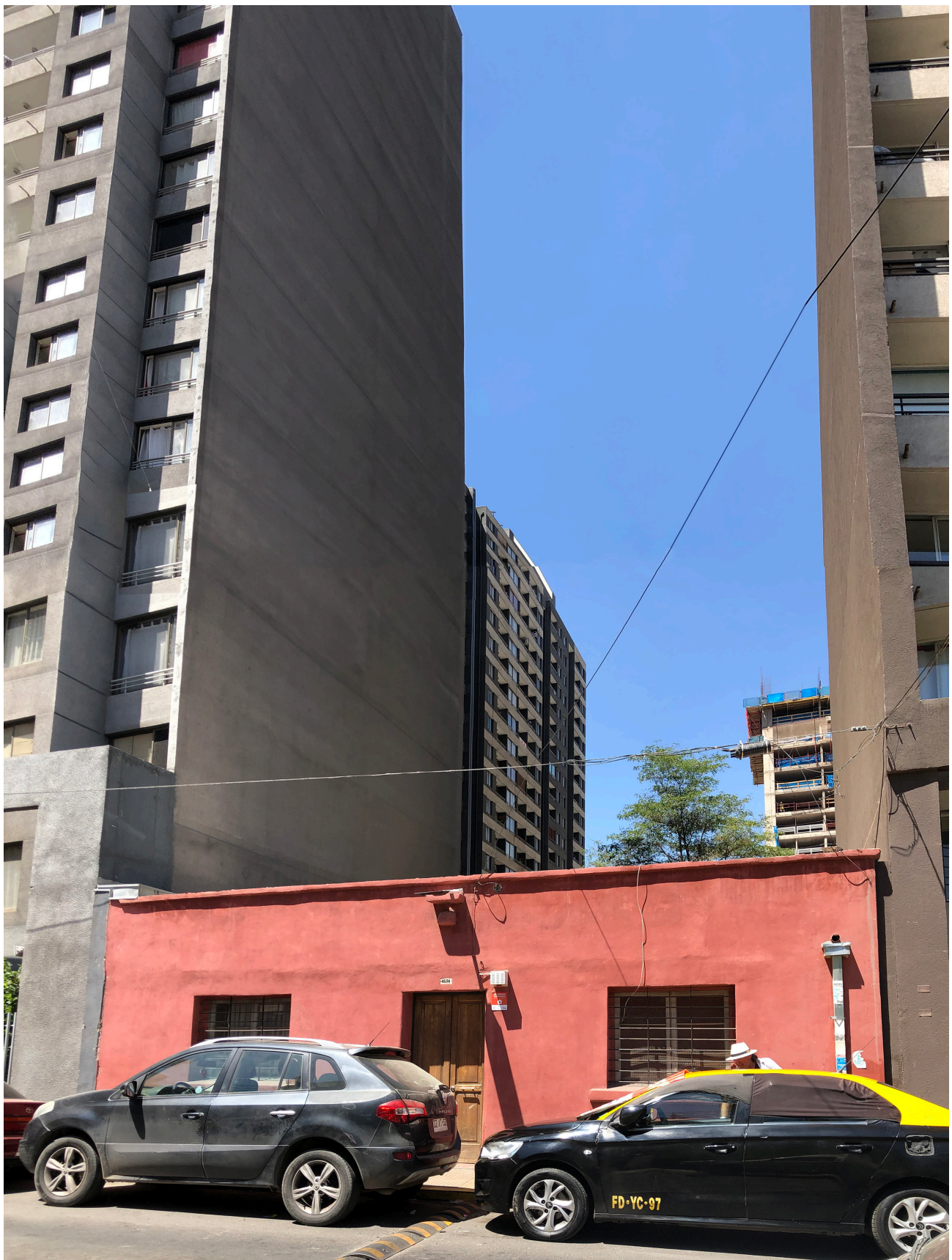
Figura 19 – Fachada Norte predio, calle Conde Maule
