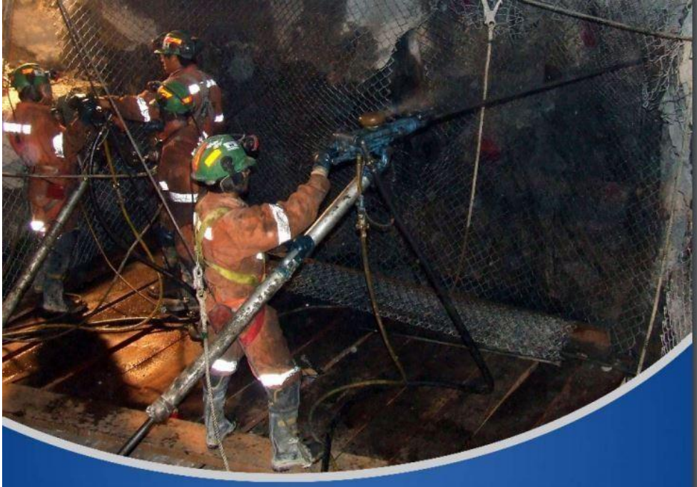
Figura 2.9: Blindaje de piques. Fuente www.acunaehijos.cl
