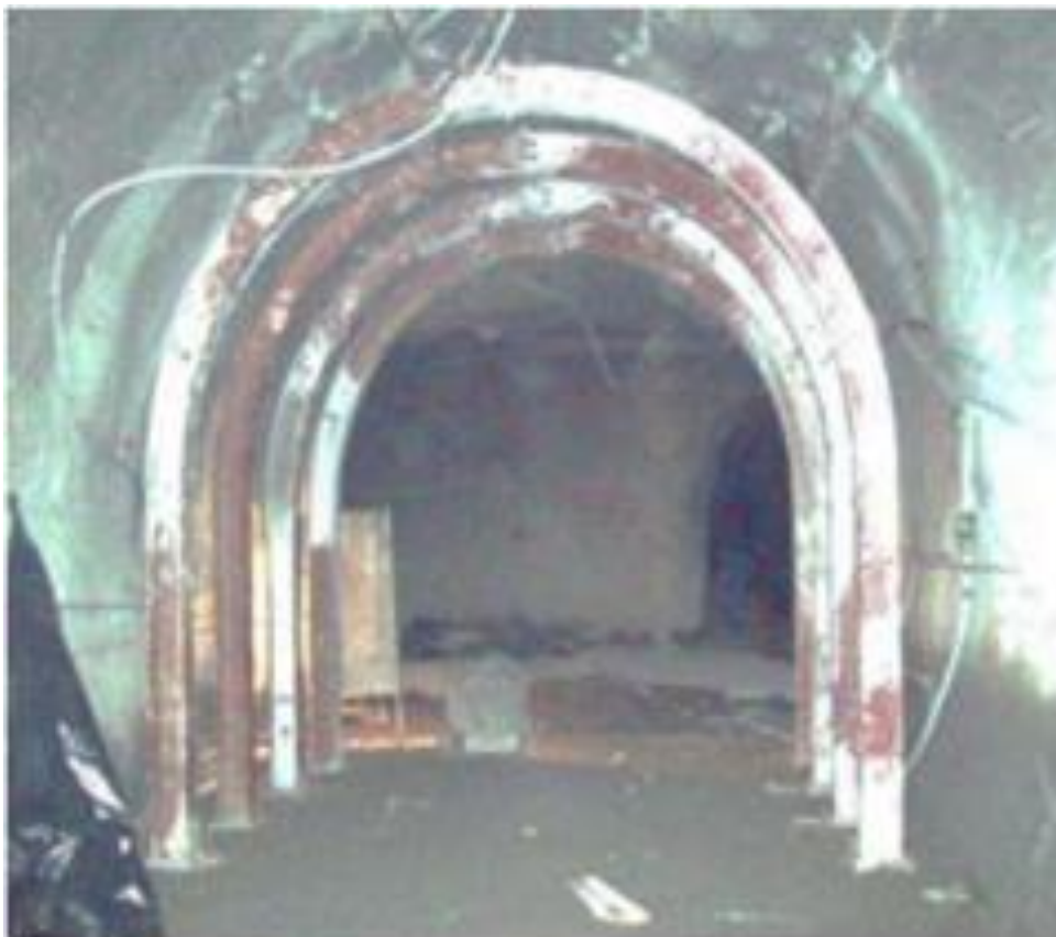
Figura 2.11: Fortificación de un Punto de Extracción
