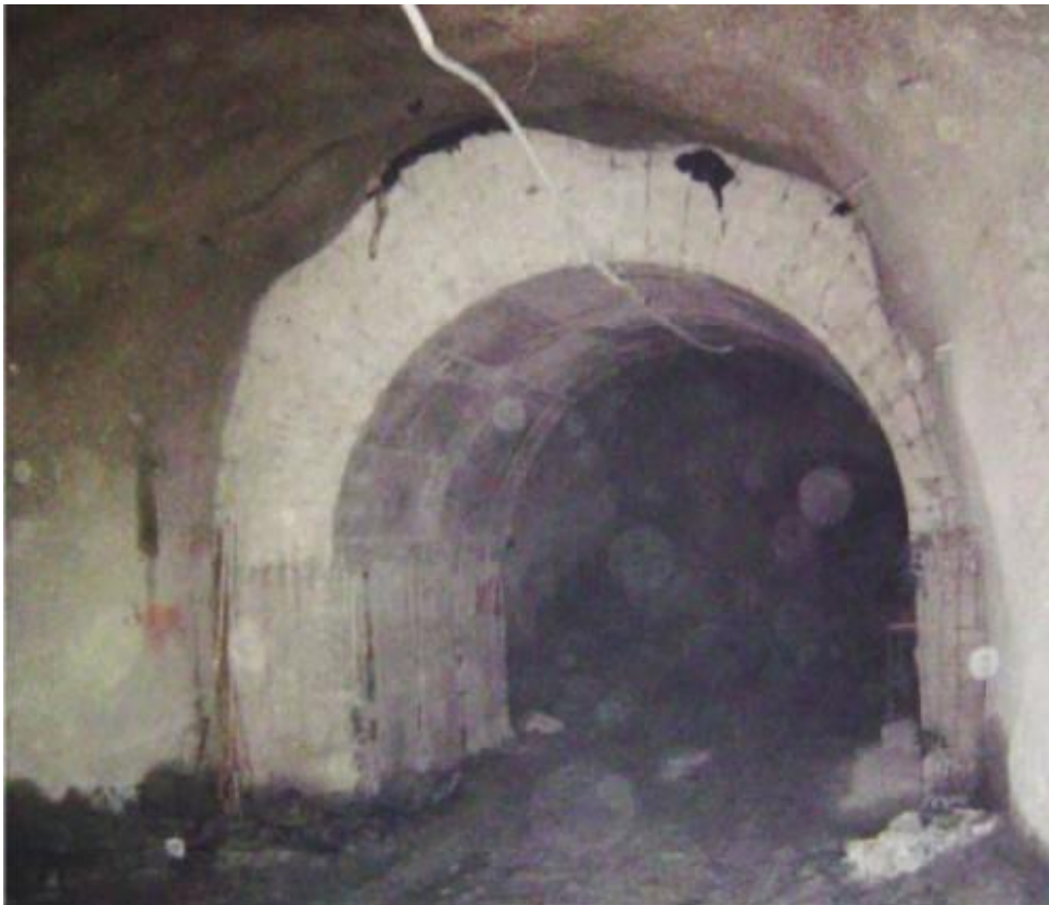
Figura 2.12: Construcción de Muros de Confinamiento
