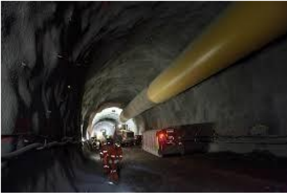
Figura 2.28: Sistema de ventilación túnel. Fuente mch.cl
