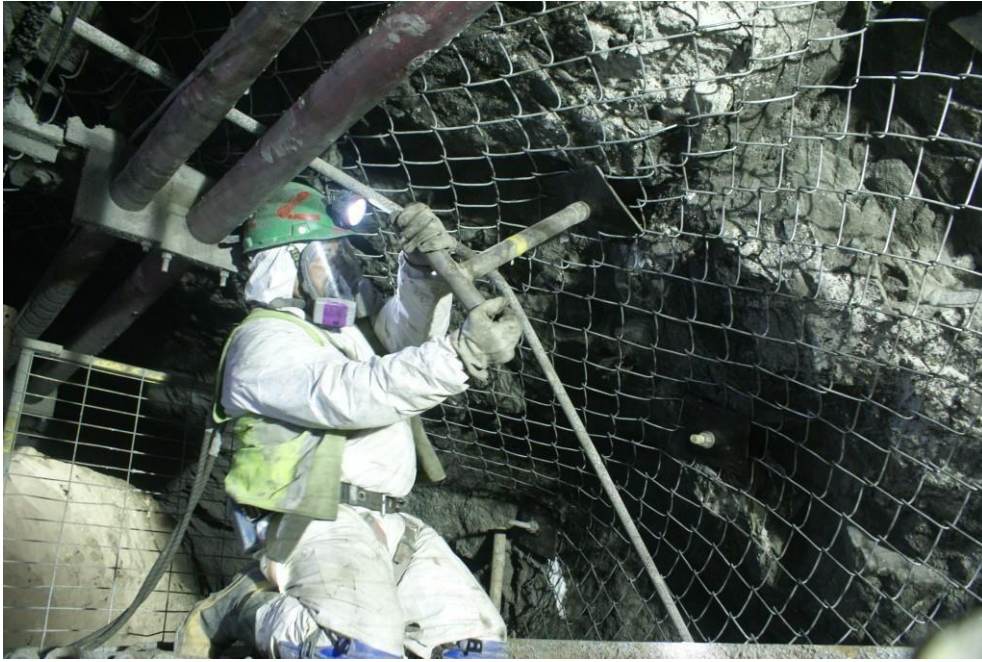
Figura 2.20: Desquinche y fortificación de pique
