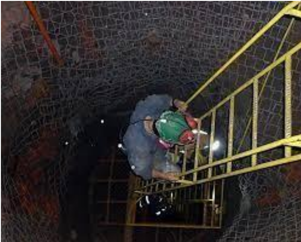
Figura 2.14: Chimenea de emergencia
