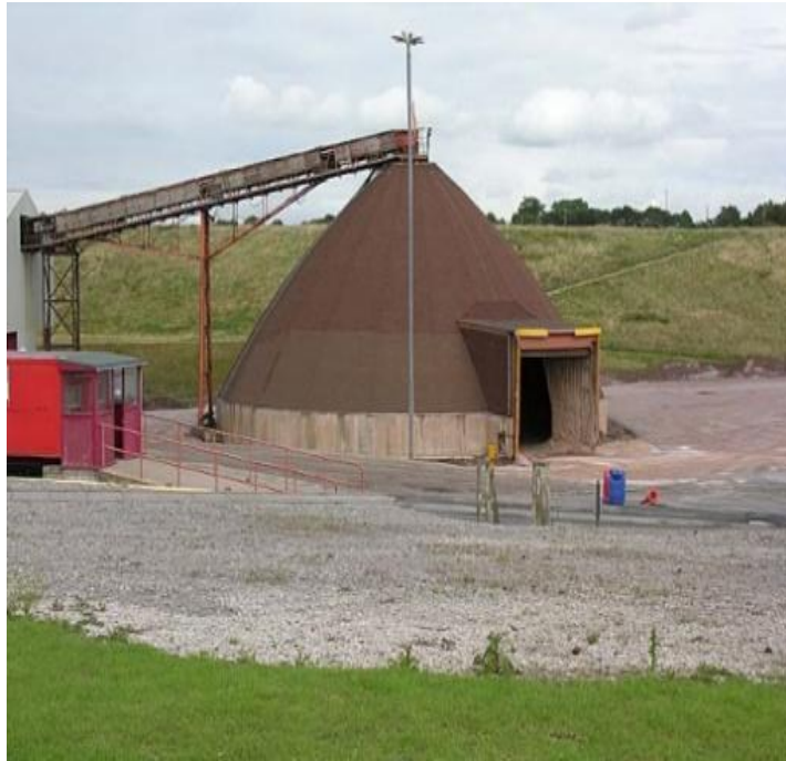
Figura 3: Stockpile que cuenta con estructura protectora.[7]
