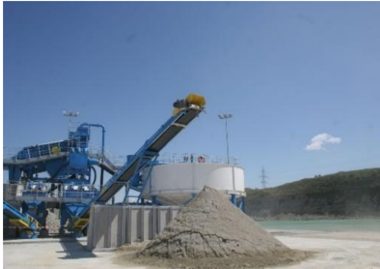
Figura 1: Descarga de material desde correa transportadora hacia stockpile.[5]
