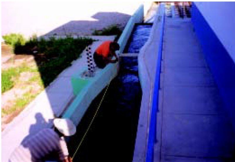
Figura 3.15: Canaleta Parshall defectuosa (CEPIS, 2004a).
