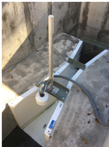
Figura 3.3: Canaleta Parshall con un sensor ultrasónico de nivel (OpenChannelFlow, 2021).
