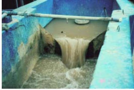
Figura 3.16: Vertedero con abertura triangular defectuoso (CEPIS, 2004a).
