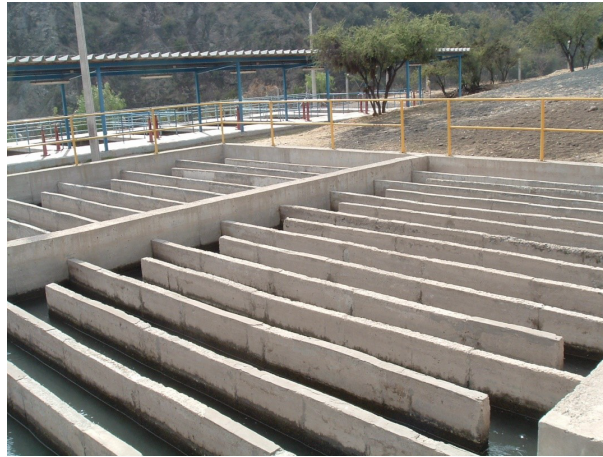
(c) Imagen del floculador de flujo horizontal de tabiques de la PTAP San Ramón (Ahumada, 2019).
