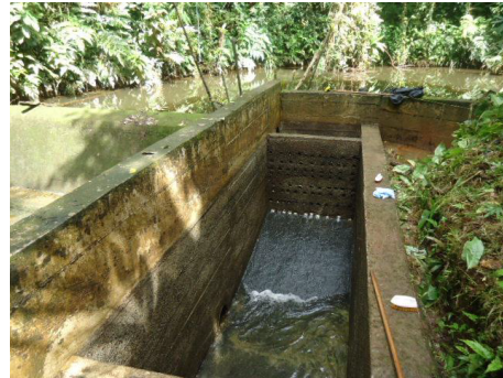
(b) Imagen de la bocatoma y desarenador de correjimiento de Bellavista. (Gómez Mejía y Ramírez de la Hoz, 2020).
