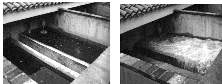
(c) Imagen de un filtro rápido gravitacional. A la izquierda el filtro se encuentra en plena carrera de funcionamiento y a la derecha se está realizando el lavado del mismo (Súarez López et al., 2014).
