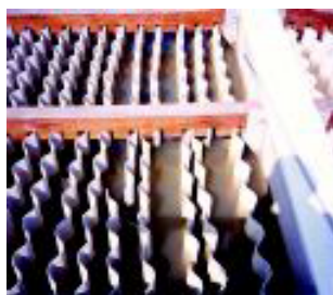
Figura 3.21: Floculador con un mal sistema de sujeción (CEPIS, 2006).
