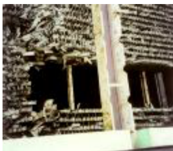
Figura 3.26: Módulos de plástico deteriorados (CEPIS, 2006).
