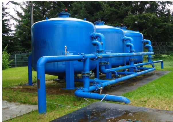
(c) Filtros Rápidos en Presión (PTAP Río Bueno - ESSAL) (Ahumada, 2019).
