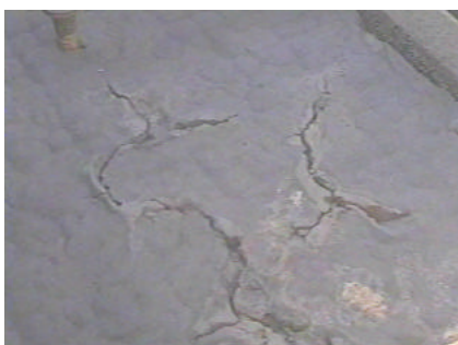
Figura 3.31: Grietas en el lecho de un filtro problemático (Bauman et al., 2006).
