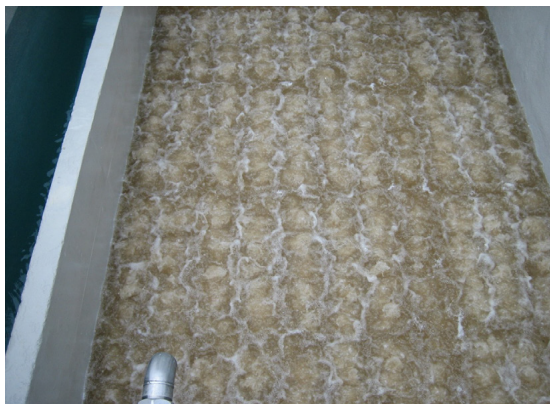
Figura 3.32: Ejemplo de un buen patrón de retrolavado (EPA, 2020).
