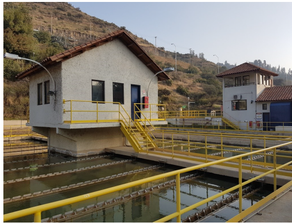
(b) Sedimentador de flujo vertical PTAP San Enrique - Aguas Cordillera (Ahumada, 2019) .
