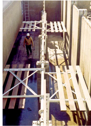
(b) Imagen de un floculador mecánico de eje horizontal de paletas (Suárez et al., 2014).
