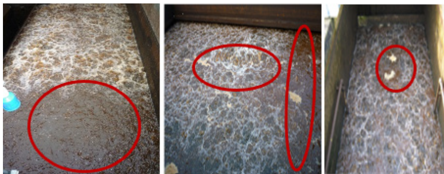
Figura 3.33: Ejemplo de patrones de retrolavado deficientes. (A) indica una zona muerta; (B) indica una zona de ebullición y un punto muerto a la derecha; (C) la acumulación de restos puede indicar una zona muerta. (EPA, 2020).
