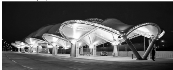
Fig 19: Vista exterior EIM Del Sol. Fuente: www.disenoarquitectura.cl
