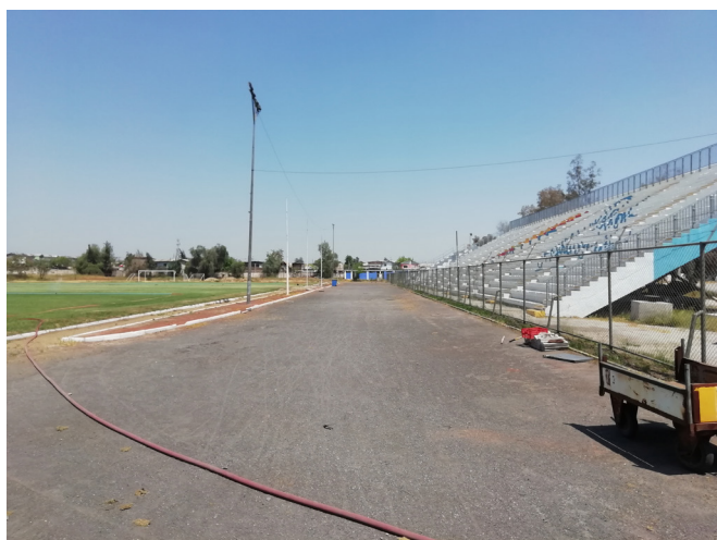
Figura 32: Estadio Municipal, Situación Actual Predio. Fuente: Elaboración Propia.
