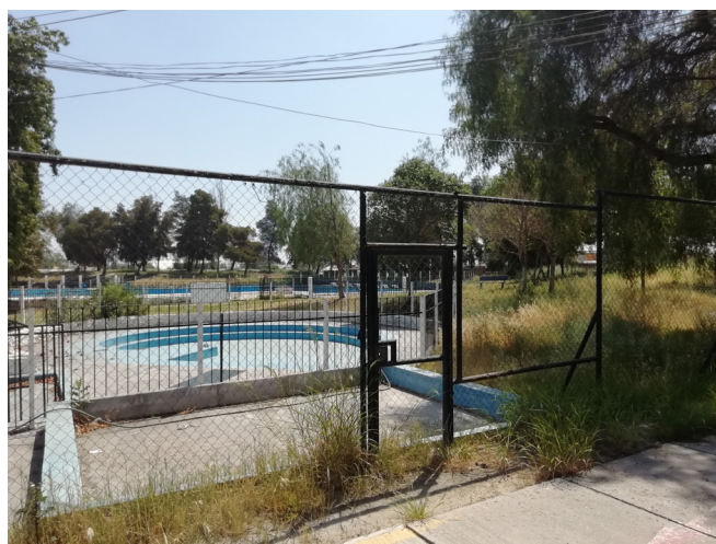
Figura 31: Piscina Municipal, Situación Actual Predio. Fuente: Elaboración Propia.
