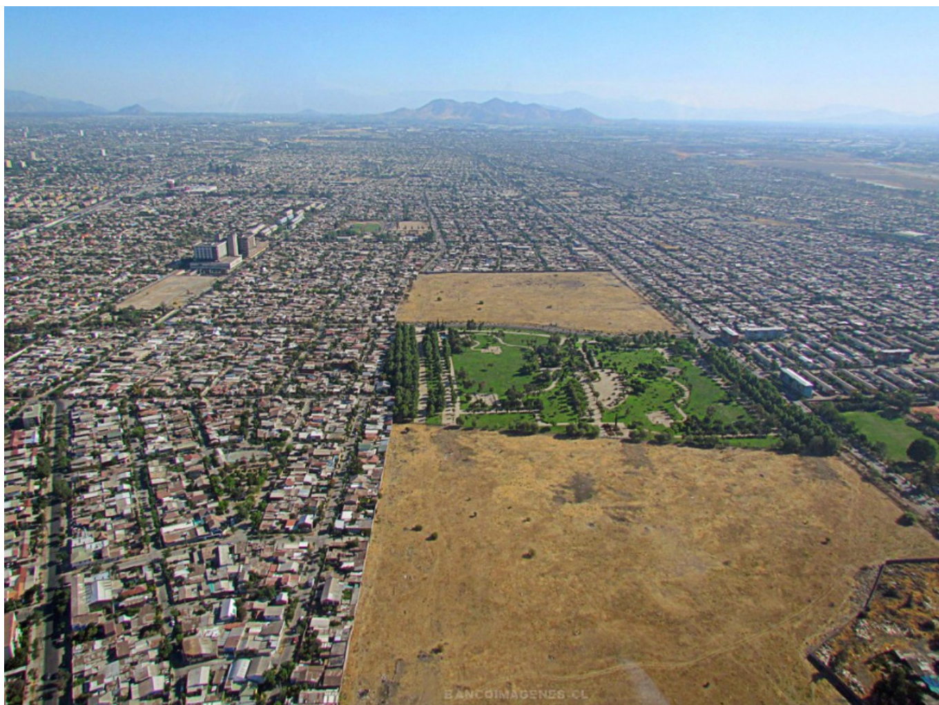
Figura 11: Vista Aérea de Alturas, Densidad y grano de la Comuna 2011. Fuente: Pablo C.M. Rescatado de Flickr.com
