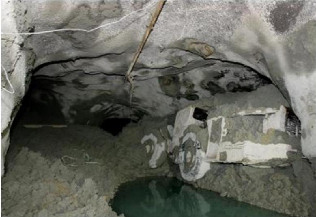
*Ilustración 1 Consecuencia de infiltración de agua barro en un proyecto minero*
