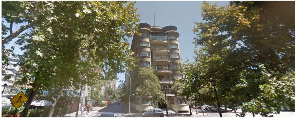
Imagen N°21: “Edificio Ismael Valdés Vergara”. Fuente: (Street View, 2015).
