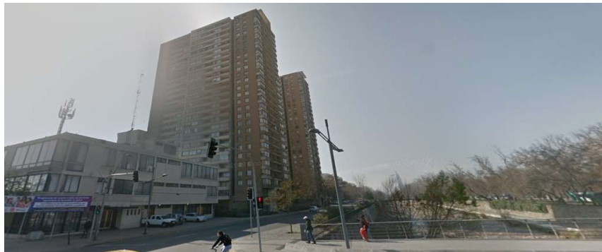
Imagen N°29: “Edificios nuevos en barrio Patronato”. Fuente: (Street View, 2015).
