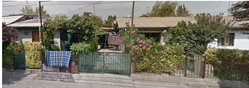
Imagen N°10: “Casas en Escrivá de Balaguer”. Fuente: (Street View, 2012).
