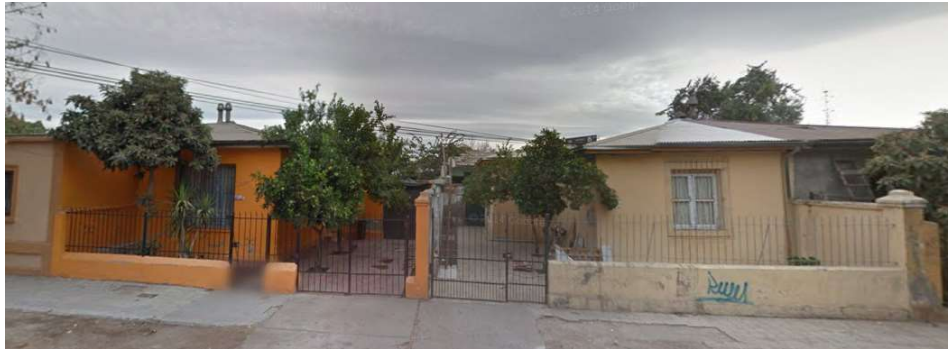
Imagen N°31: “Casas en pasaje Cuatro Norte”. Fuente: (Street View, 2014).
