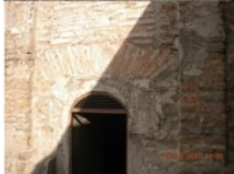
Fractura pasada en muro de acceso a Campanario.
