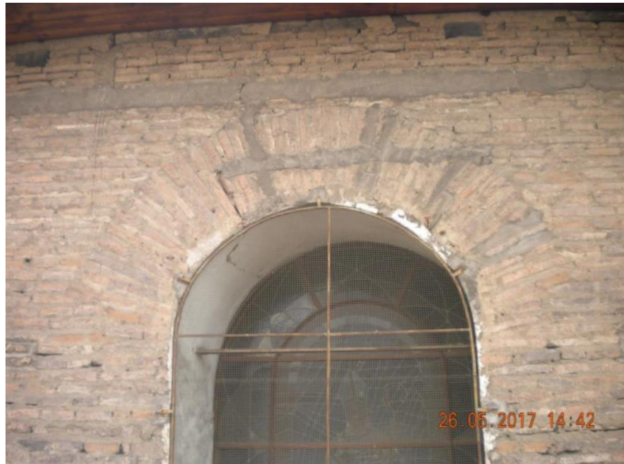
Anexo 28. Pérdida de mortero en ladrillos en sardinel. (Arriostro Ingenieros, 2017) Fuente: Informe del estado estructural del edificio. Arriostro ingenieros.
