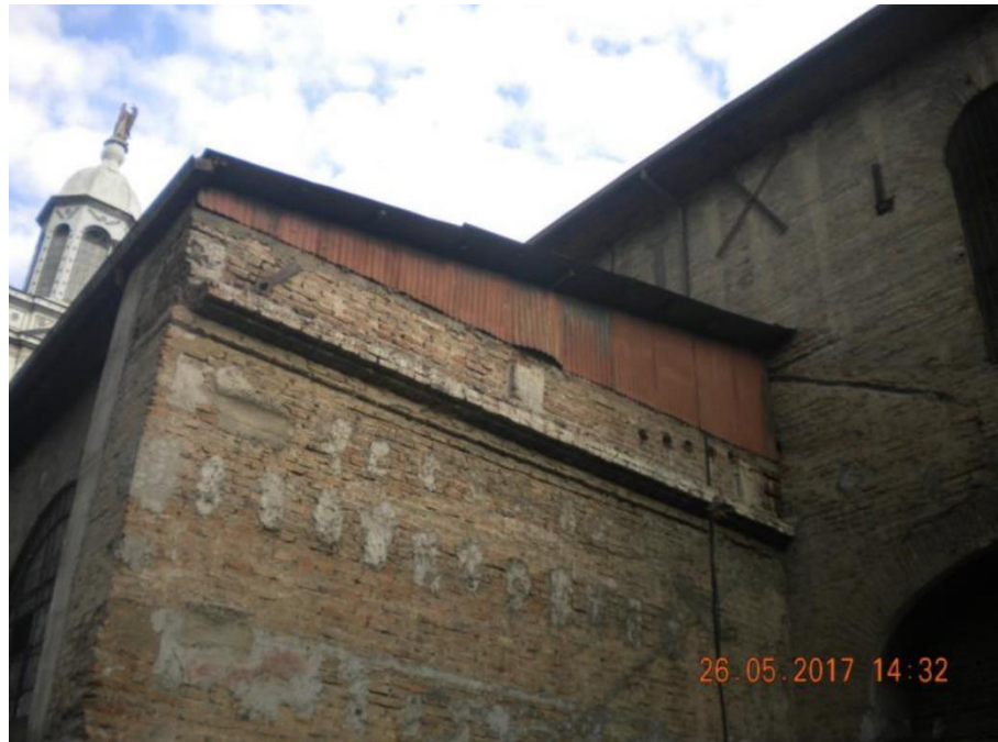
Anexo 24 Separación leve de muros por vaciamiento sísmico. (Arriostro Ingenieros, 2017) Fuente: Informe del estado estructural del edificio. Arriostro ingenieros.
