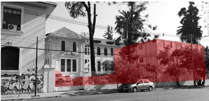
5.-Fachada norte del Instituto del Cancer en la calle Profesor Zañartu.
