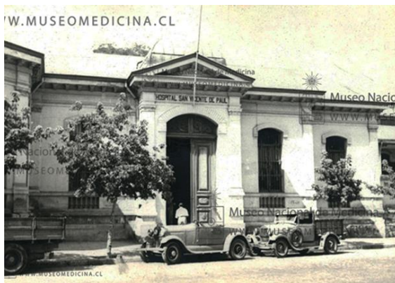
Figura 40: Fachada del Hospital San Vicente de Paul hacia la Avenida Independencia. 71
