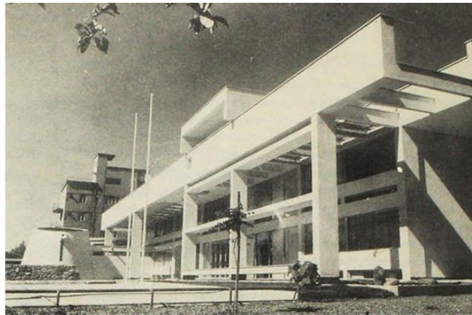
Figura 82: Fotografía de fachada exterior del SEMDA de la Universidad de Chile. 121
