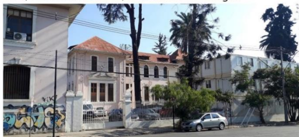
VISTA 2 , Fachada Profesor Zañartu, Instituto del Cáncer.
