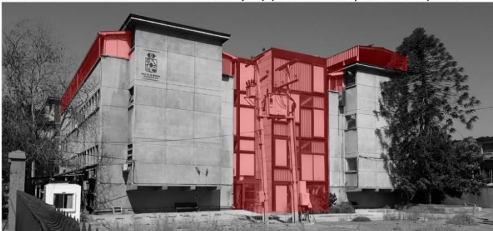
4.-Fachada poniente de la Escuela de Medicina frente a Estación Metro Hospitales.
