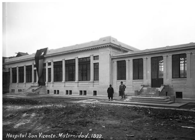
Figura 74: Fotografía del patio interior de la Ex-Maternidad del Hospital San Vicente de Paul. 114
