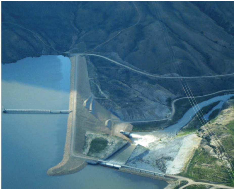
Figura 2.12: Muro de la presa de agua Ritschard, en Colorado, Estados Unidos. Fuente: Lorenz[32]
