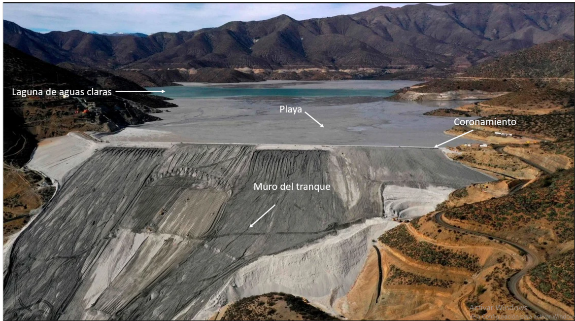
Figura 1.3: Tranque de Relaves El Mauro, Comuna de Los Vilos. Vista NE del muro. Fuente: Bernetti(2019)[4]
