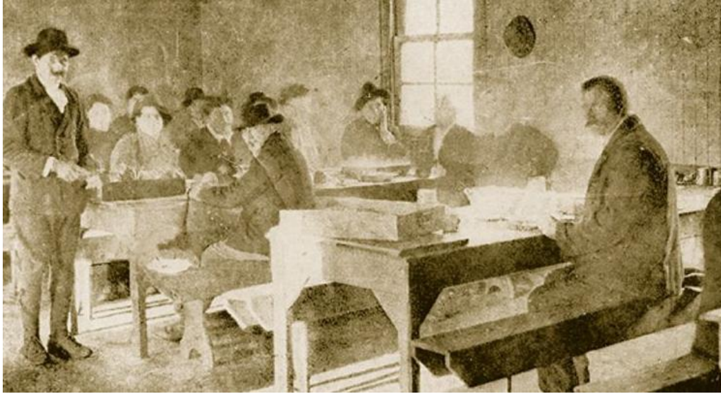
Comedor para trabajadores en la estancia Cameron, Tierra del Fuego, 1920
