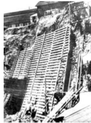
Figura 7. «Vista de un muro de retención a eslabones que retiene la tierra, deja filtrar el agua y permite retener terraplenes de hasta 50 m de altura».
