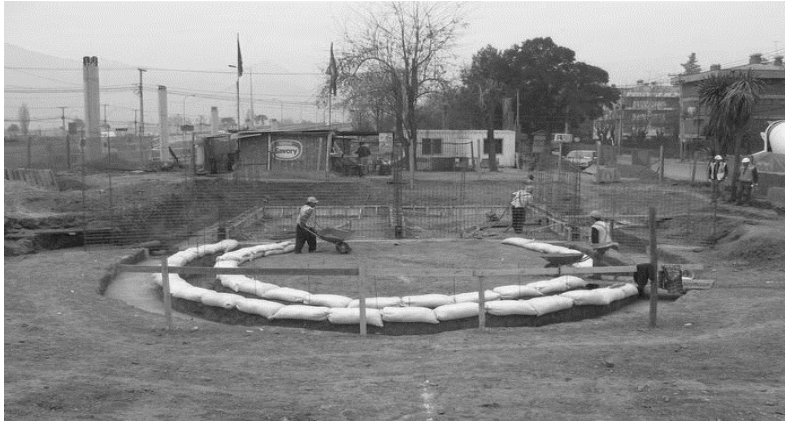
Imagen 4. Inicio de la construcción del Anfiteatro. (2003). Archivos fotográficos Biblioteca Arcilla Negra, Conchalí, Santiago.
