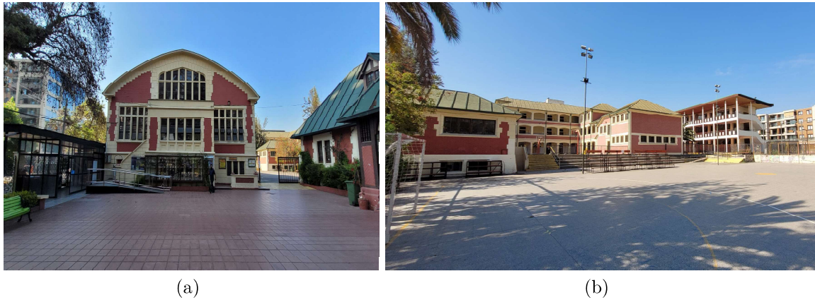
Figura 4.4: Liceo Experimental Manuel de Salas (a) Gimnasio y (b) Pabellones. Fuente: Elaboración propia.
