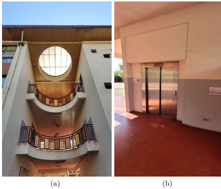
Figura 4.19: Pabellón Alberto Arenas (a) Claraboya y (b) Ascensor. Fuente: Elaboración propia.
