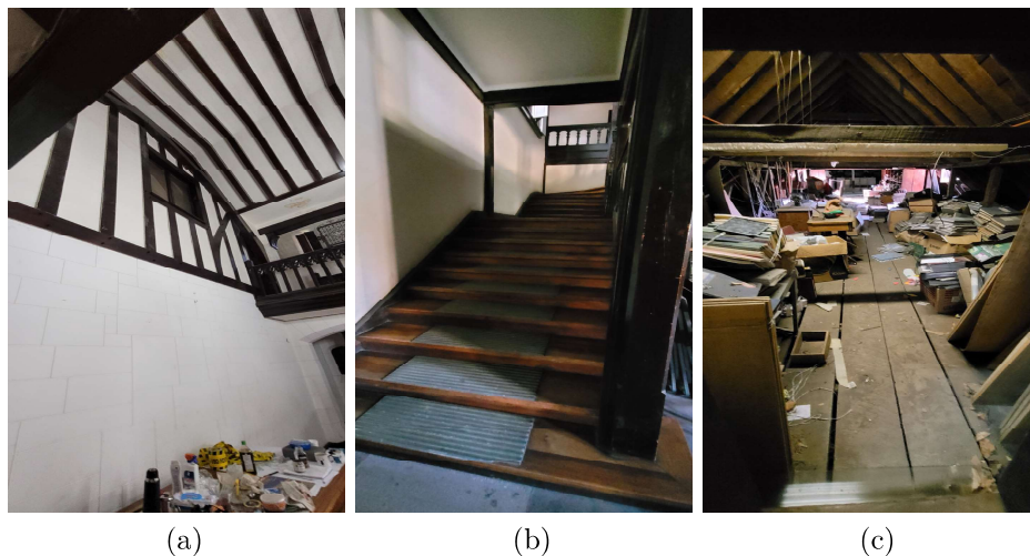
Figura 4.23: Casona (a) Muros, (c) Escaleras y (d) Entretecho. Fuente: Elaboración propia.
