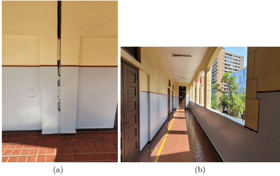
Figura 4.16: Pabellón Viola Soto pasillos (a) Juntas y (b) Pasillo ala oeste. Fuente: Elaboración propia.
