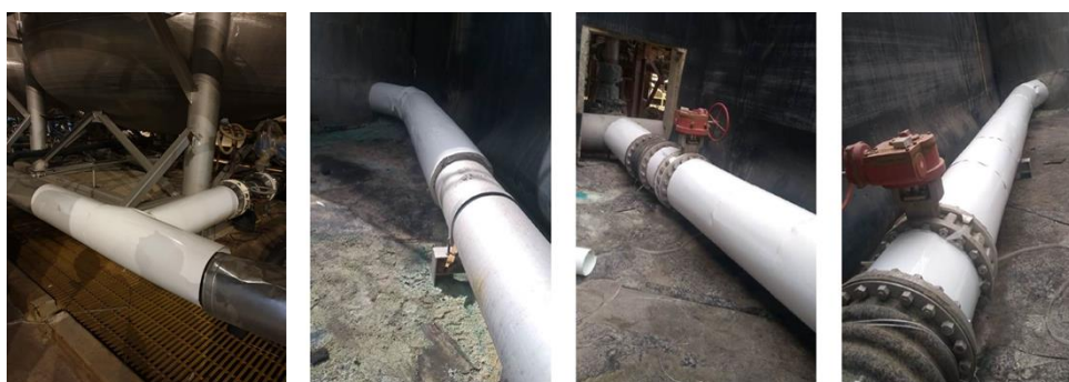
Figura 13 Instalación aislación térmica
