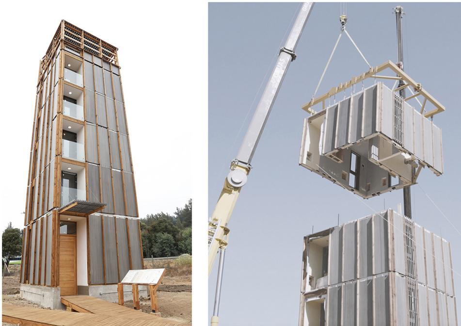
Figura 2.6: Montaje de la Torre.
