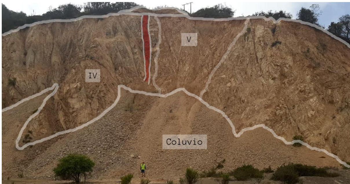
Figura 4.26: Arriba: Estructura del Talud 4. Abajo: Perfil de meteorización Talud 4.
