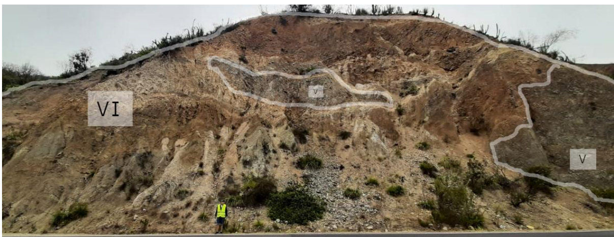
Figura 4.25: Perfil de meteorización Talud 3.
