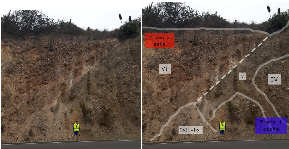
Figura 4.23: Perfil de estructura mayor en Talud 2.
