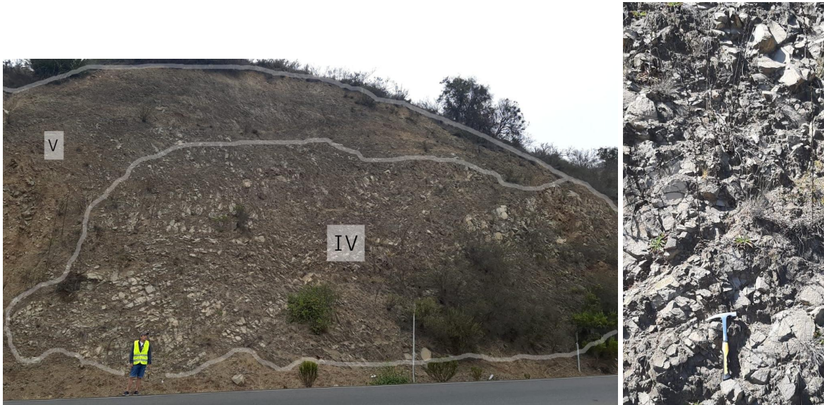
Figura 4.22: Derecha: Perfil de meteorización Talud 2 Tramo oeste. Izquierda: Estructura en bloques del Talud 2 Tramo oeste.
