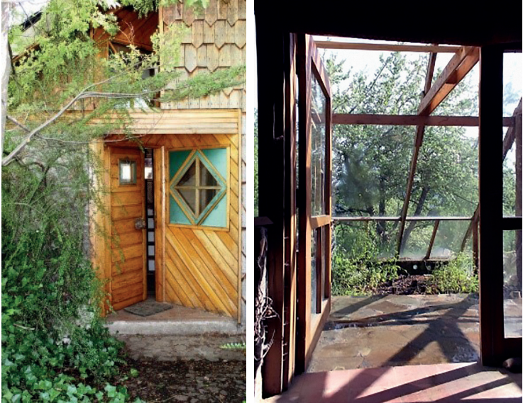
Abbildung 131 und 132 Haupttür und Zugang zum Gewächshaus.
