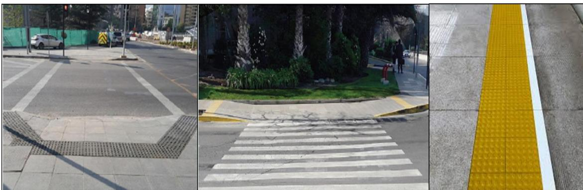
Figura 7-8: Rebaje de solera y plinto nulo en cruce peatonal (izquierda y centro), Huella podotáctil (derecha)
