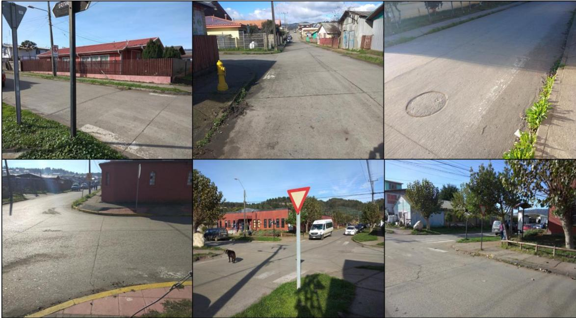
*Figura 4-25: Cruces peatonales demarcados en mal estado*
