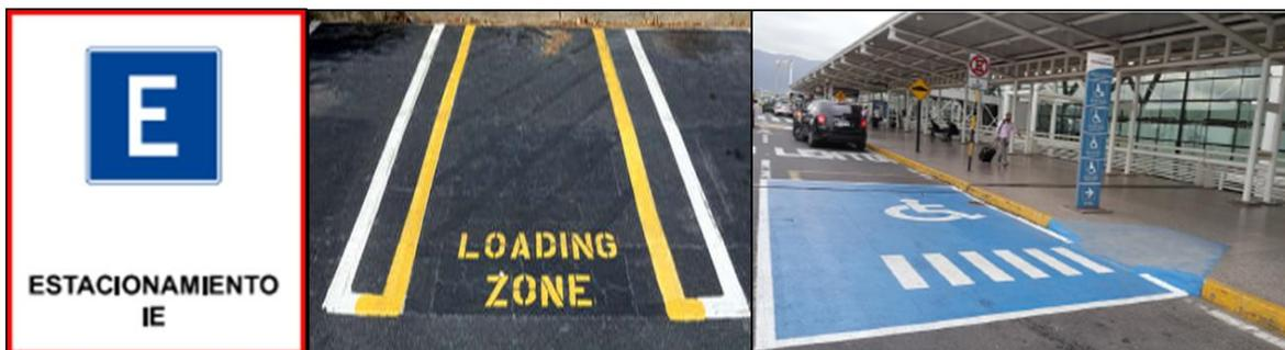
*Figura 7-12: Señal informativa de estacionamiento (izquierda), Demarcación en calzada de zona de carga y descarga (centro), Demarcación en calzada de espacio de estacionamiento para personas con movilidad reducida (derecha)*
