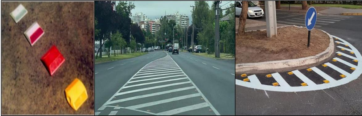
Figura 7-6: Tachas (izquierda), Demarcaciones de achurado en calzada con incorporación de tachas (centro y derecha)
