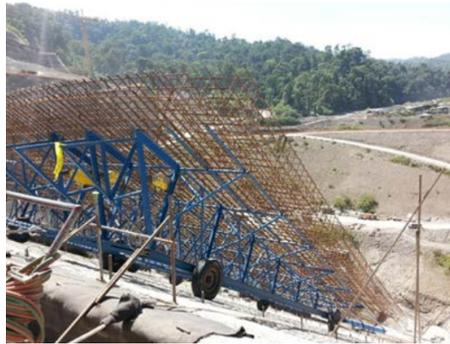
Figura C.7: Carro transporte de mallas de acero de refuerzo. Fuente: Astaldi (2015).
