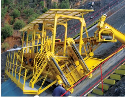
Figura C.6: Hormigonada de la pantalla de presa. Fuente: Astaldi (2015).
