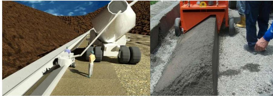
Figura C.4: Construcción del Bordillo Extruido. Fuente: Astaldi (2015).
