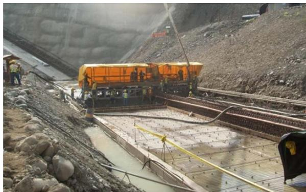
Figura C.3: Construcción del plinto. Fuente: Astaldi (2015).
