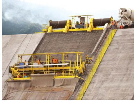
Figura C.8: Hormigonado pantalla presa con formaleta deslizante. Fuente: Astaldi (2015).
