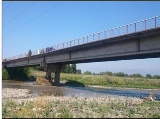
Figura 26. Ejemplo de puente con vigas de hormigón. [19]
