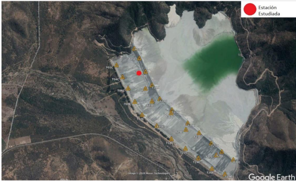
Figura 36: Ubicación de la estación "T07" en el tranque de relaves.
