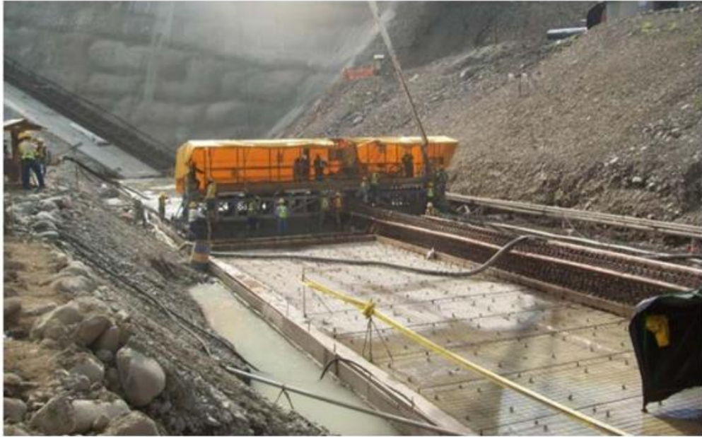
Figura 8-6: Construcción del plinto.
