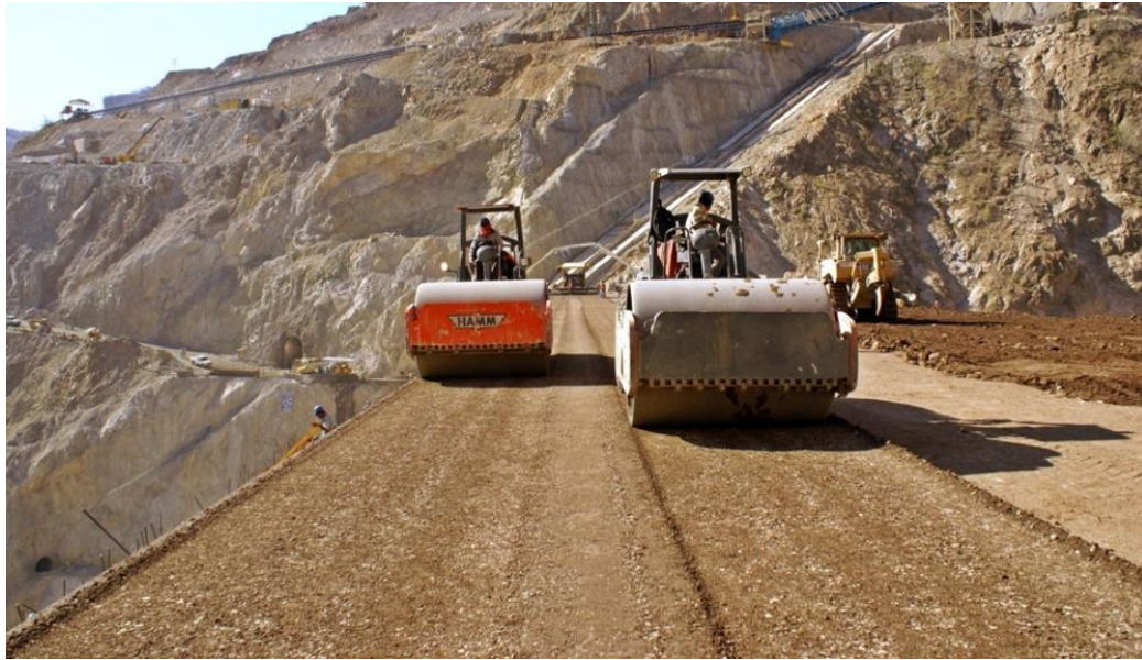
Figura 8-5: Compactación material tipo 2B. Presa La Yesca-México.
