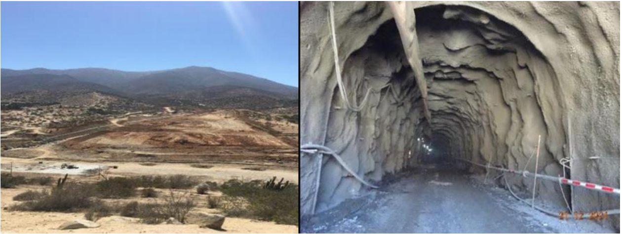
Figura 8-11: Vista general de la zona del muro principal y del túnel de desvío.
