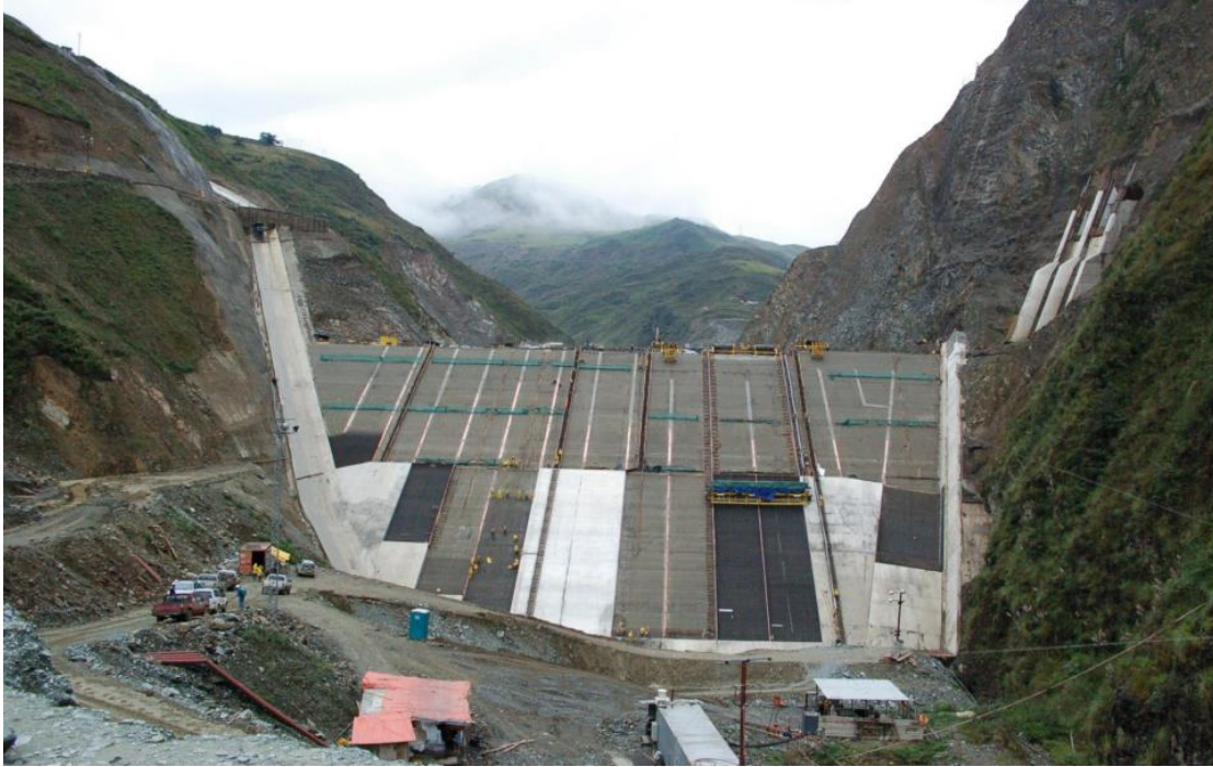
Figura 2-1: Construcción de presa tipo CFRD.
