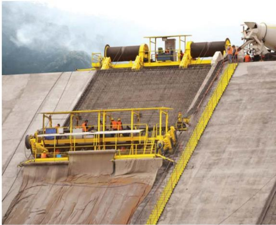
Figura 8-8: Hormigonado de la pantalla de la presa con encofrado deslizante.
