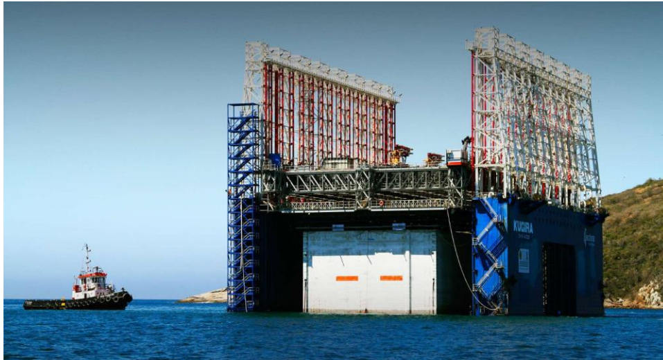
Figura XXVII: Fabricación de cajones con cajonera flotante “Kugira”. Fuente: Acciona
