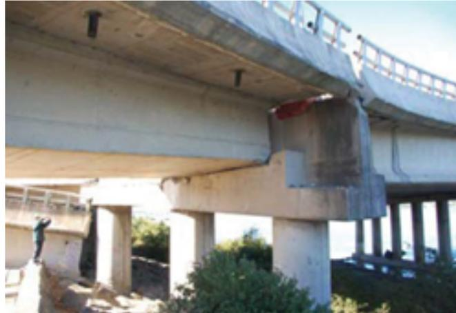
Figura 2.10: Elevación y desviación hacia el exterior en un soporte extremo interior [7]
