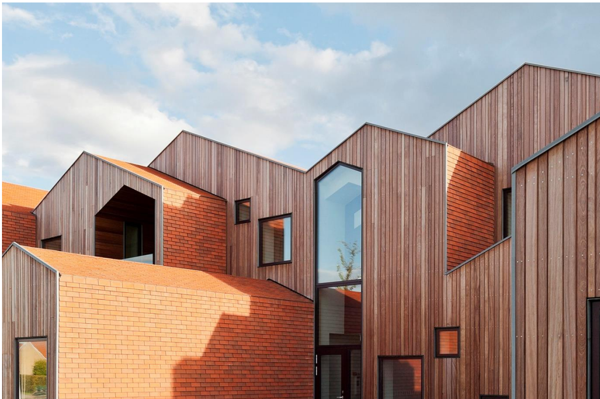
Imagen 8 Hogar de Menores CEBRA Fuente: Plataforma Arquitectura
