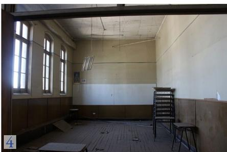
4 Vista interior de salas en tercer nivel (2017). Existe desgaste en pavimentos y daños en luminarias
