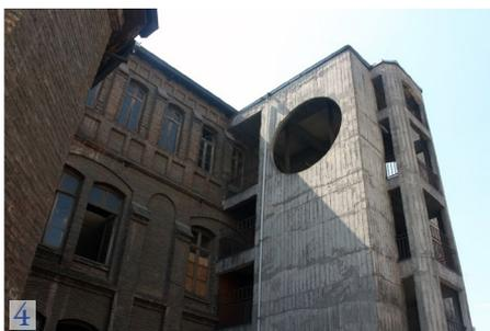
4 Adosamiento de la caja de escaleras de hormigón armado a la fachada sur (2017).
