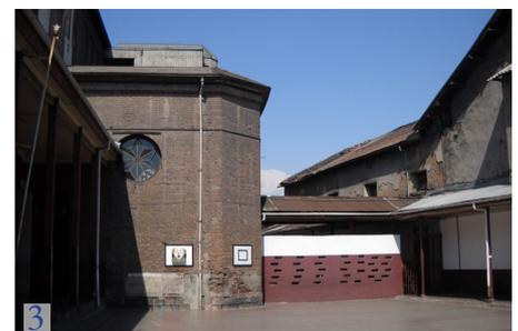
3 Vista exterior de la caja de escaleras (2017). Presenta manchas por suciedad y heladicidad en los elementos de albañilería en la zona inferior.
