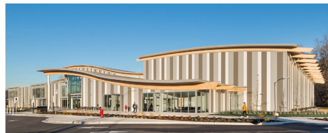
Vista exterior e interior del proyecto Fuente: https://structurecraft.com/
