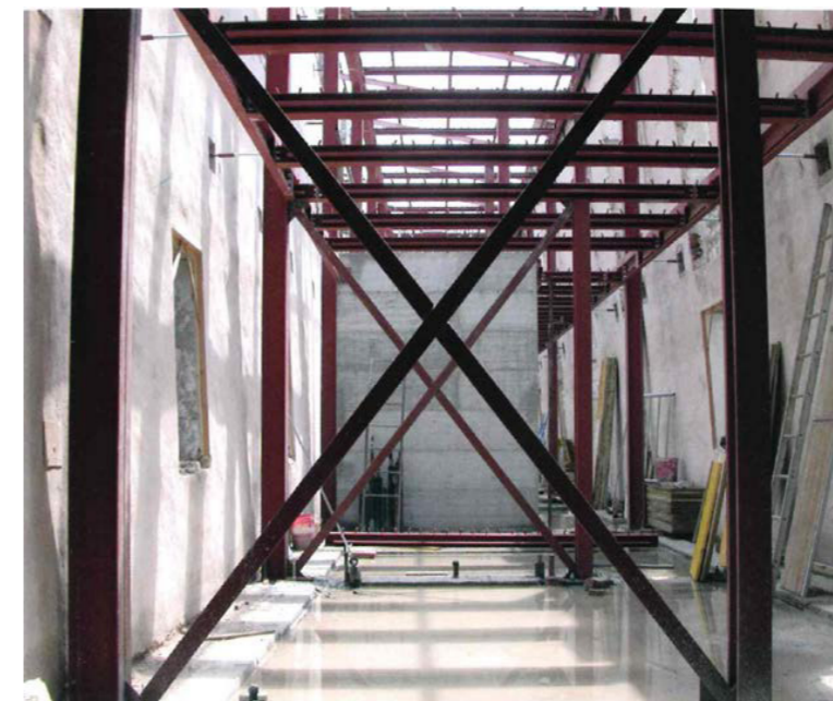
Fig. 82. Referente: Villa Contarini, Foresterie vecchie. Intervención de consolidación estructural de la preexistencia.
