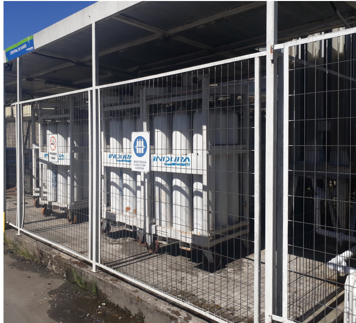
Figura 4.20: Cilindros de oxígeno comprimido de respaldo.
