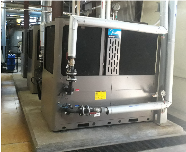
Figura 4.7: Vista frontal de la Bomba de calor aerotérmica fabricante Midea modelo RSJ-800/SZN1-H.
