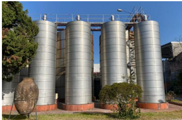
Figura 4.18: Estanque de almacenamiento de agua seleccionado.
