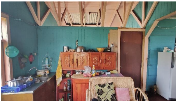
Fotografía 18: María. Cocina ampliada. Ausencia de cielo y división entre espacios. Registro propio.
