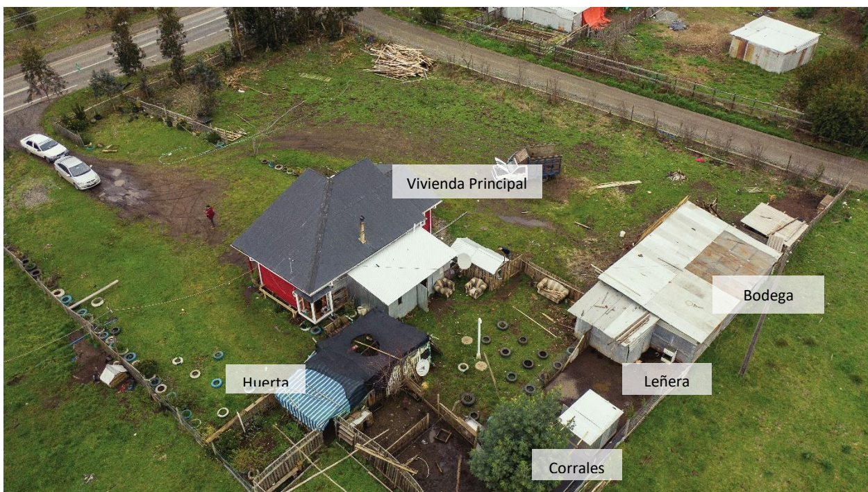
Fotografía 59: Vivienda de Elizabeth, entorno próximo construido. Registro propio.
