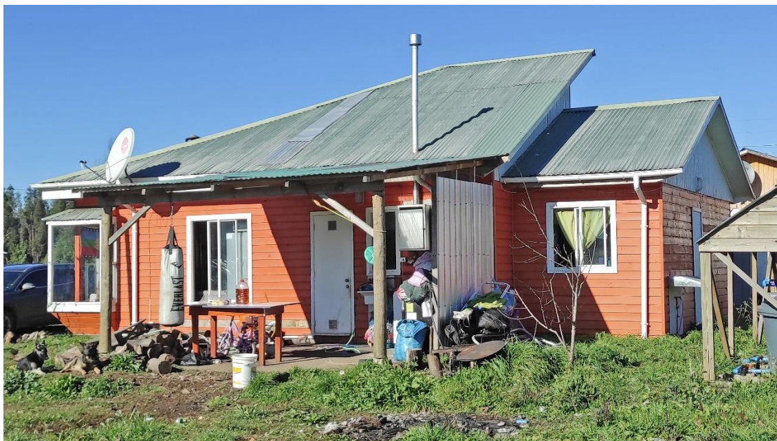
Fotografía 57: Agustina. Ampliación de cobertizo y radier en sector posterior . Registro propio.
