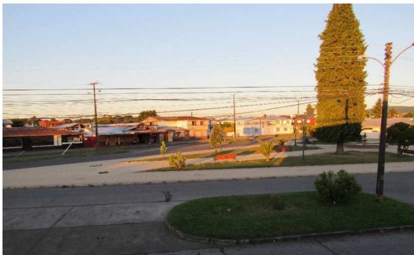
Fig. 38. Vista del eje principal de Toltén, Av. O'Higgins. Fuente: elaboración propia.
