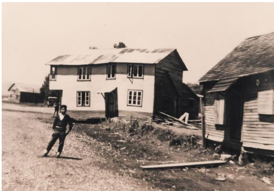
Fig. 19. Registro del estado de las construcciones después del terremoto de 1960. Fuente: Biblioteca de Toltén.
