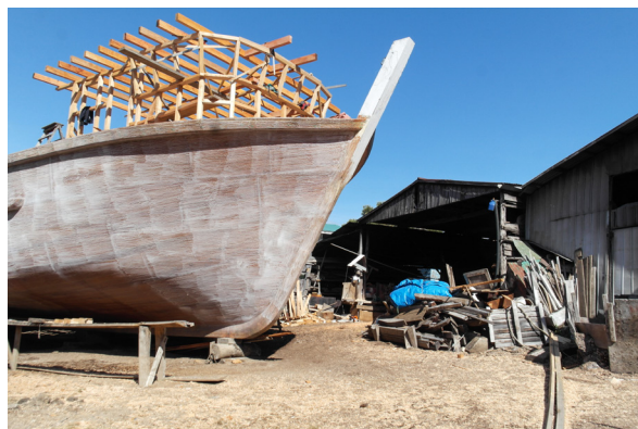
Figura 39 Embarcación en construcción a cielo abierto Fuente: Colección de la autora (marzo 2021)
