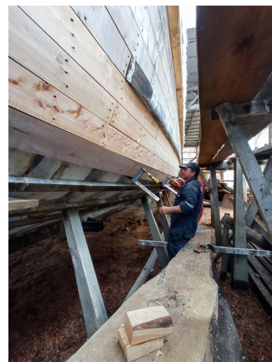
Figura 136 Detalle entablado lateral Fuente: Elaboración propia 2021
