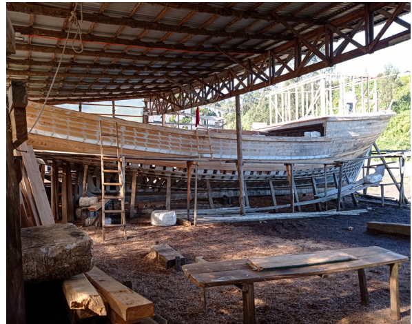
Figura 203 Elementos de apoyo: andamios, escaleras, puntales Fuente: Fuente: Colección de la autora (octubre 2021)
