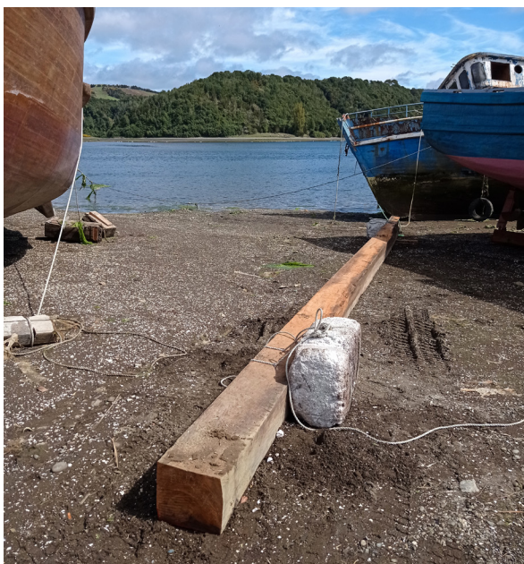
Figura 123 Traslado de quilla a zona de construcción Fuente: Colección de la autora (octubre 2021)
