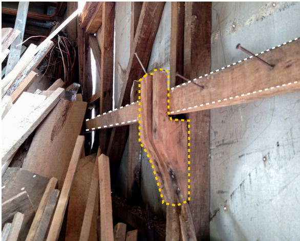
Figura 202 Traba puerta de acceso a galpón Fuente: Elaboración propia 2021
