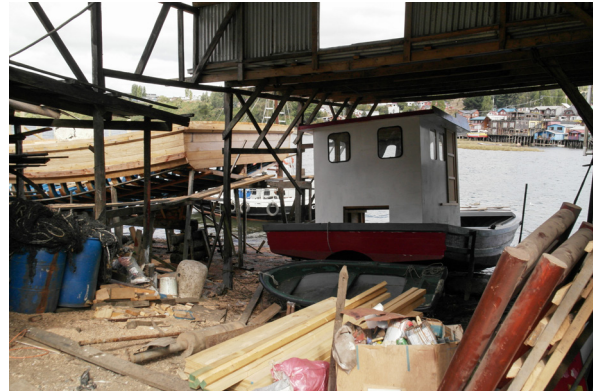
Figura 44 Embarcación en construcción en galpon semi cerrado Fuente: Colección de la autora (octubre 2021)
