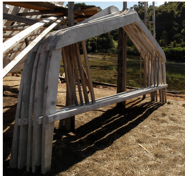
Figura 128 Plantillas guardadas en astillero Fuente: Colección de la autora (marzo 2021)
