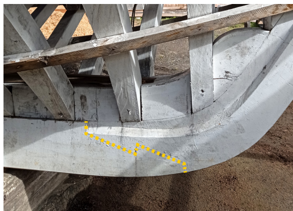
Figura 200 Unión entre quilla y roda mediante rayo de júpiter Fuente: Elaboración propia 2021
