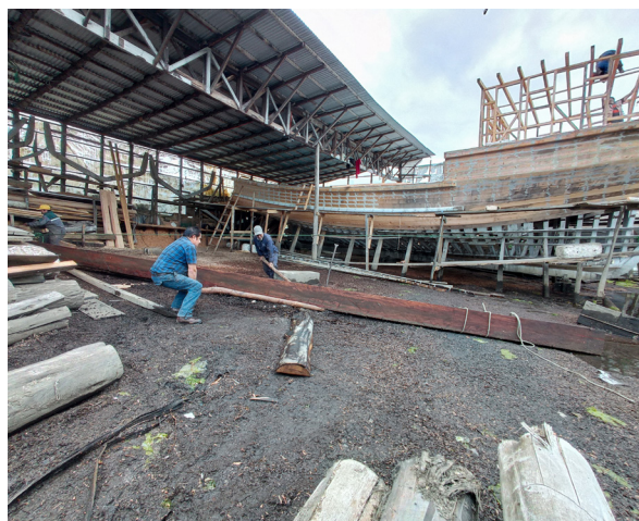
Figura 126 Traslado de quilla a zona de construcción Fuente: Colección de la autora (octubre 2021)
