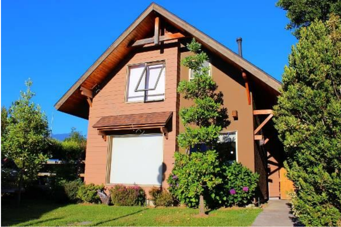
Figura 15 – Fotografía General de vivienda tipo en condominio Casas del Bosque.
