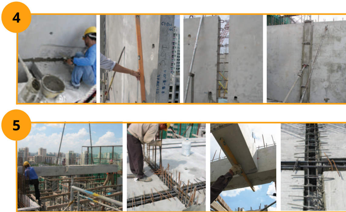
Figura 5.8: Instalación de paneles verticales(4) y horizontales(5) de hormigón. Fuente: CONQUAS 21.
