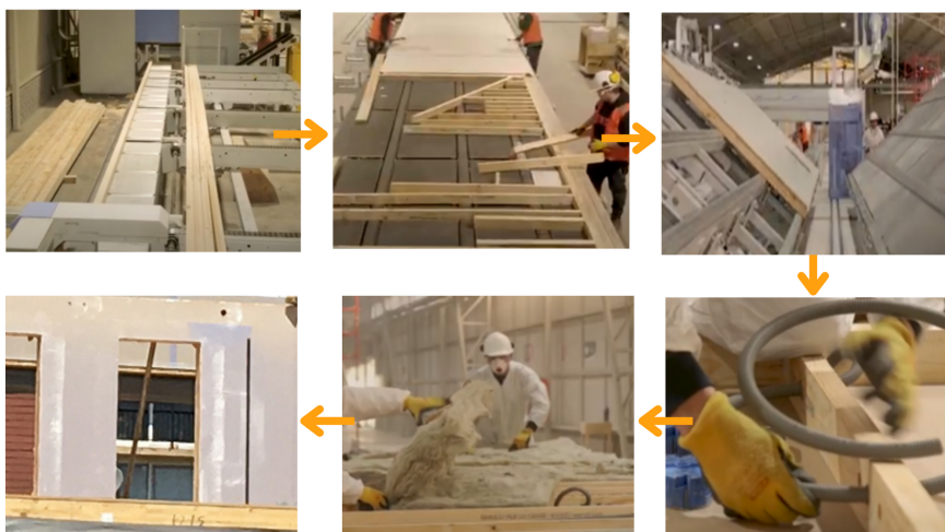
Figura 5.3: Fabricación de elementos prefabricados de madera. Fuente: E2E.
