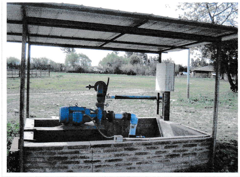
Figura 17. Sistema de bombeo hacia pradera natural
