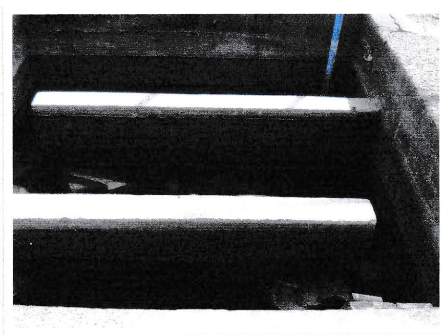
Figura 13. Pozo decantador N°2
