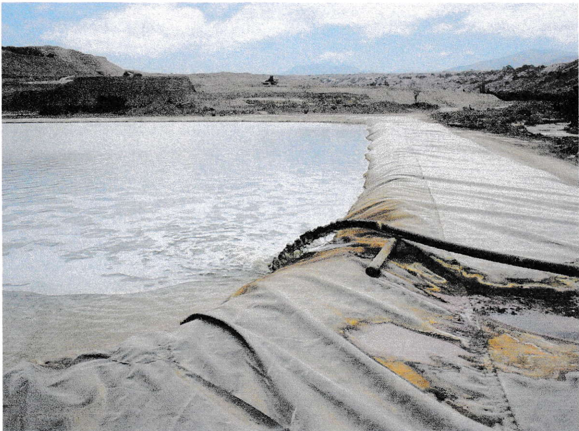
Figura 29. Estanque de sedimentación planta La Cocinera de ENAMI
