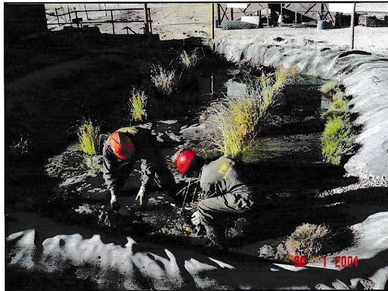
Figura 12. Construcción de la planta de tratamiento.
