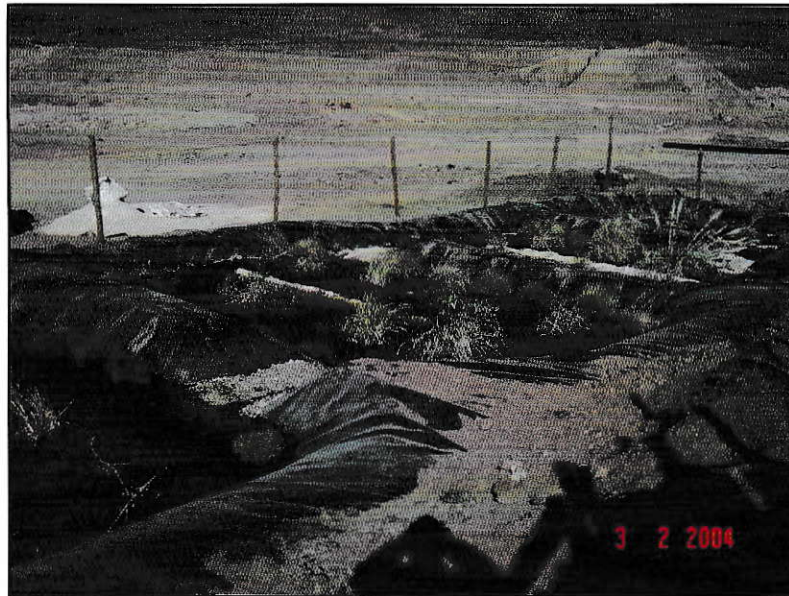
Figura 13. Construcción de la planta de tratamiento. Situación Febrero 2004
